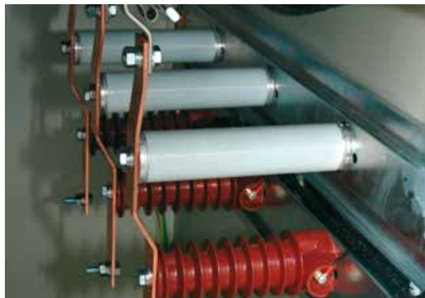
ASW in feeder bay of the transformer station Überspannungsableiter Typ ASW als Sicherung der Leitung innerhalb der Station
