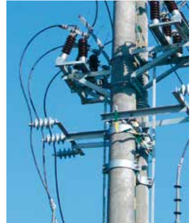
protection of MV cable – outlet of overhead line Sicherung der Mittelspannungsleitung – Ableitung der Freileitung
