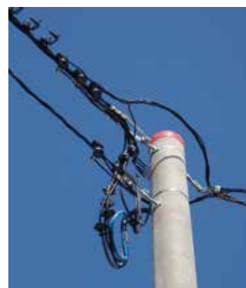
The end of the low voltage overhead line Enden der Niederspannungsfreileitung
