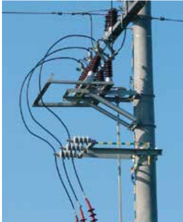
protection of MV cable – outlet of overhead line Sicherung der Mittelspannungsleitung – Ableitung der Freileitung
