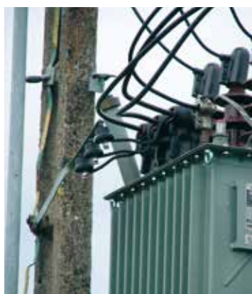
Beginning of the LV overhead line Anfang der Niederspannungsfreileitung
