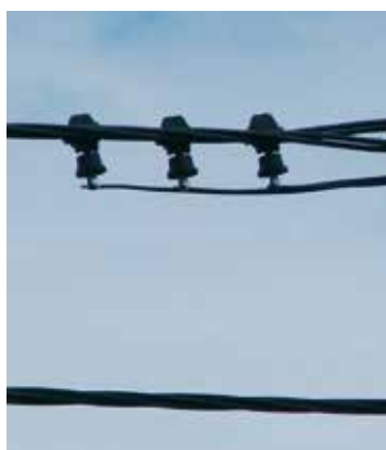
Main line 1 set of ASA every 500 m Hauptfreileitung Satz der ASA je 500 m
